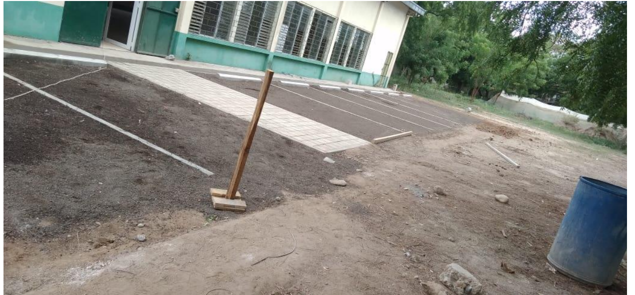
5. Relleno con pedrín negro.
