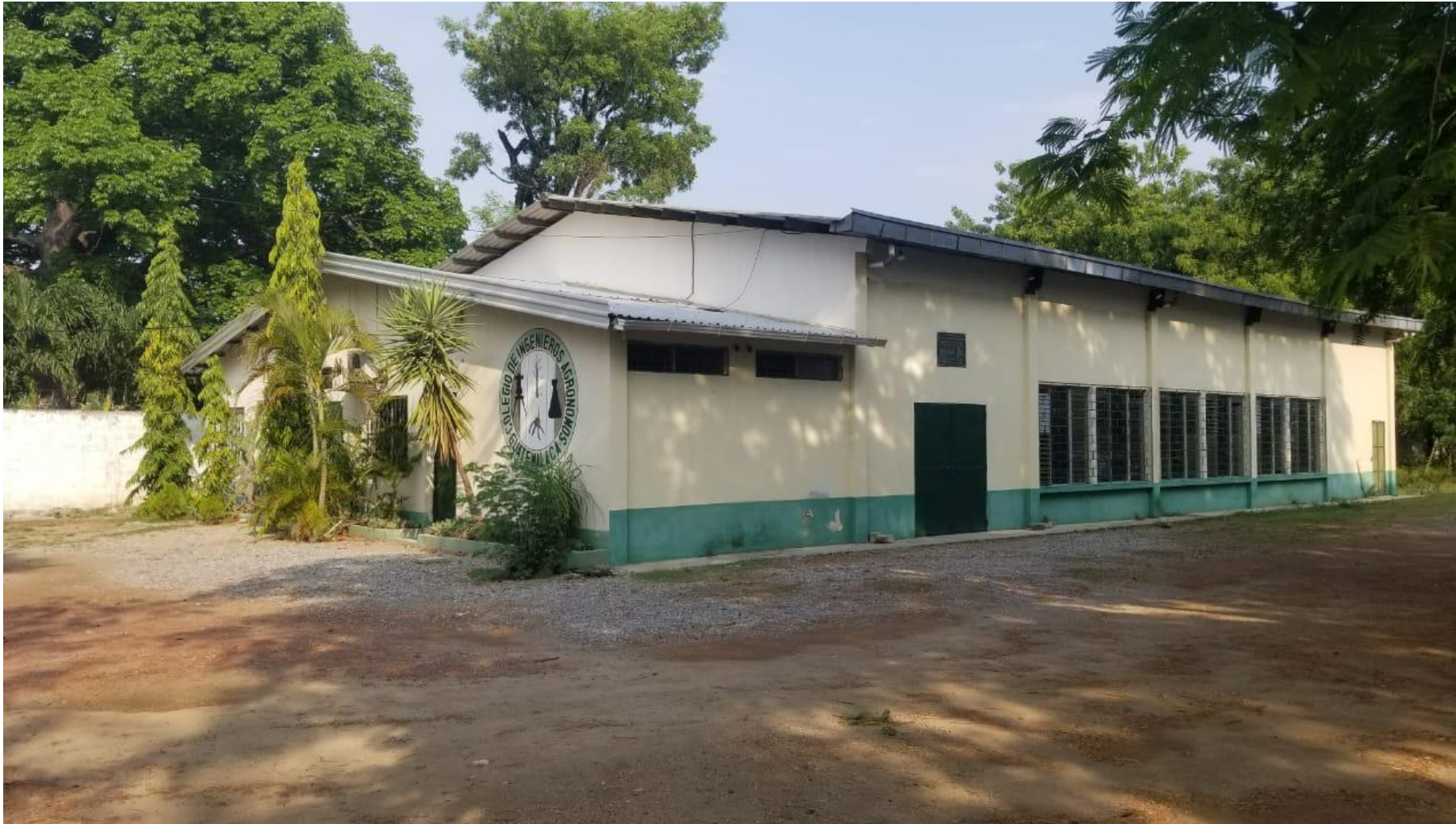
1. Estado actual del área a trabajar
