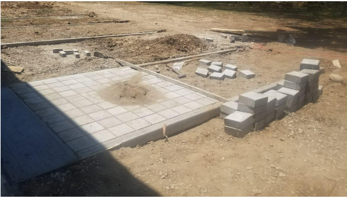
4. Adoquinamiento en ingreso principal a salón
