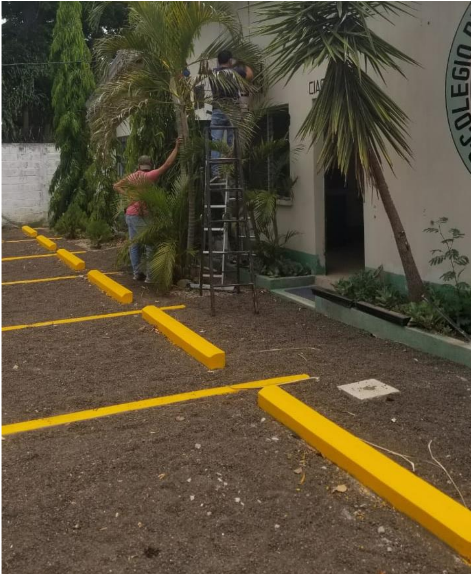
7. Pintura en bordillo y topes finalizado
