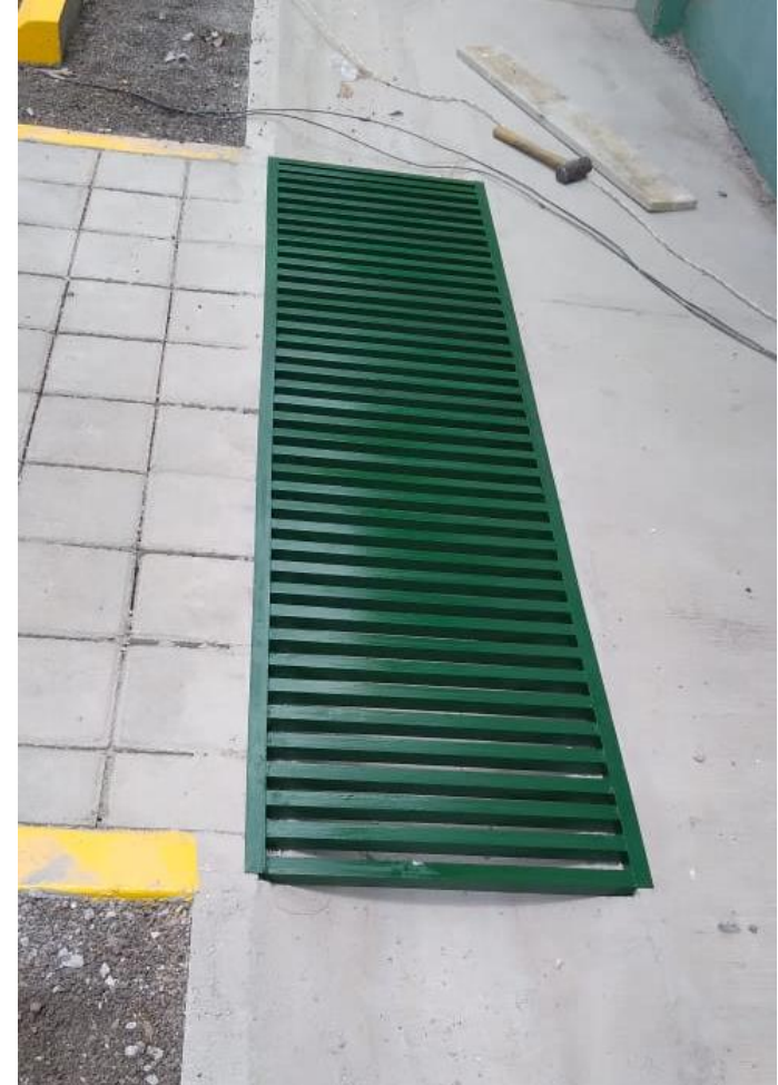
7. Construcción de rejilla en ingreso principal a salón
