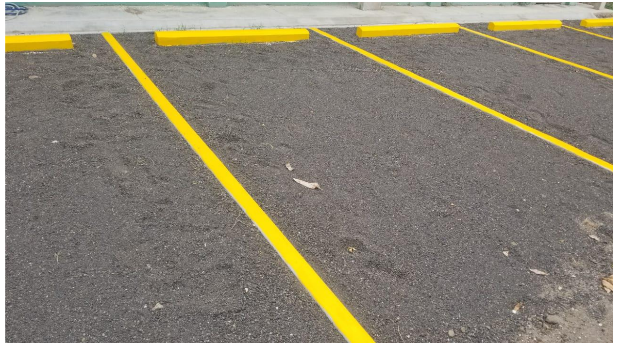
8. Pintura en bordillo y topes finalizado
