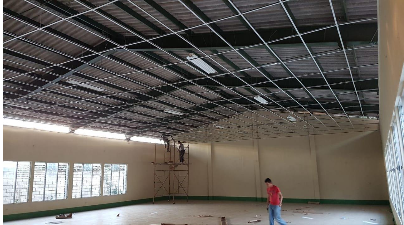
2. Instalación de estructura para cielo falso
