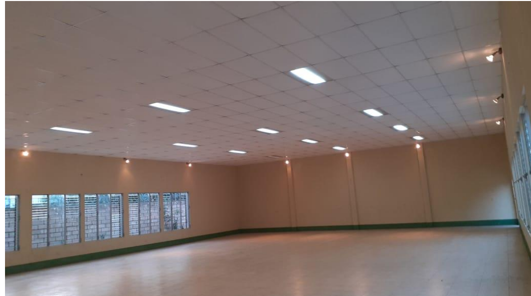
5. Instalación de cielo falso finalizado
