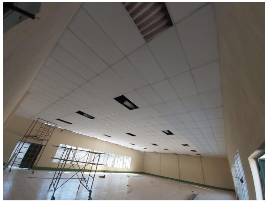
3. Inicio de colocación de cielo falso
