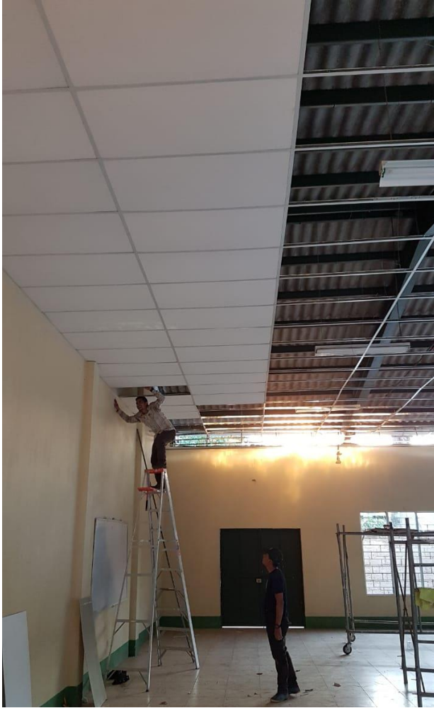
3. Inicio de colocación de cielo falso
